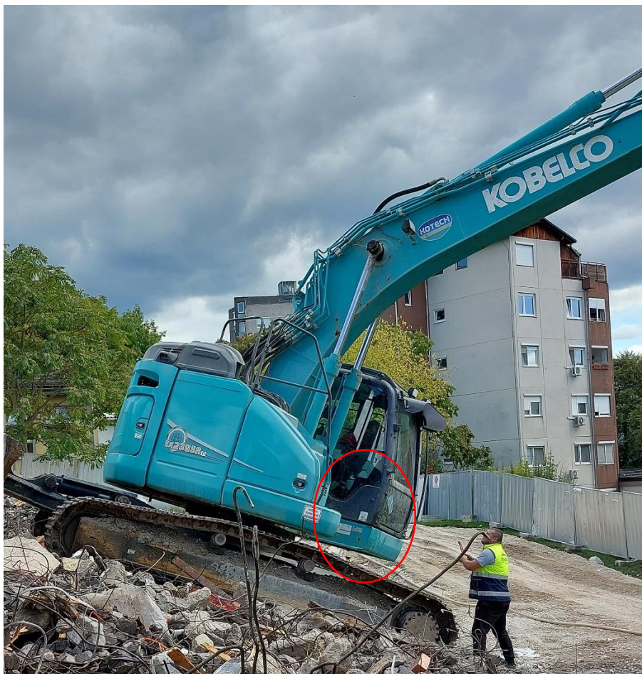
Slika 4: Pogled na delovni stroj za rušitev s klešči, L_{WA} = 97 dBA
