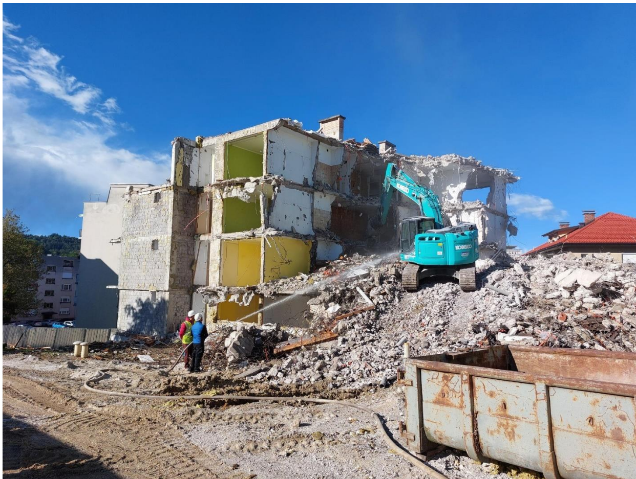
Slika 5: Pogled na izvajanje rušitvenih del in močenje
